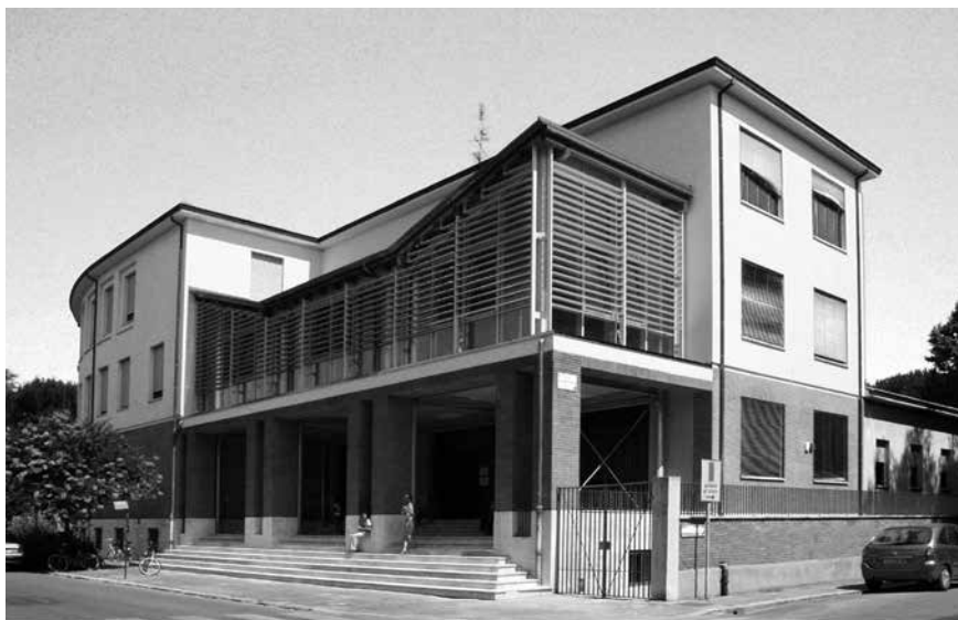
Densificazione pubblica in centro storico a Faenza. Ampliamento di scuola media. Arch Claudio Coveri 2007
