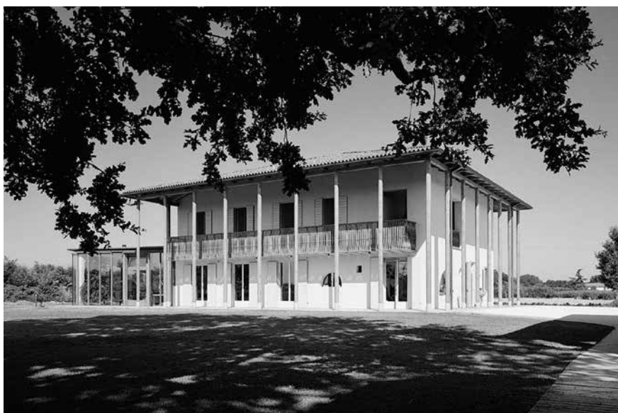
Recupero contemporaneo di edificio rurale, 2010 Arch. Davide Cristofani, arch. Gabriele Lelli
