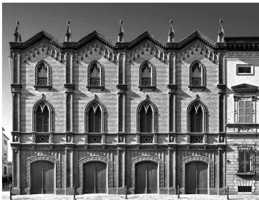
La dismissione di questo edificio pubblico (ex caserma) a privati ha consentito lo splendido recupero della facciata neogotica nelle adiacenze della piazza di Faenza. Restauro di palazzo Valenti (2014) – arch. Alessandro Tabanelli arch. Daniele Cappelli
