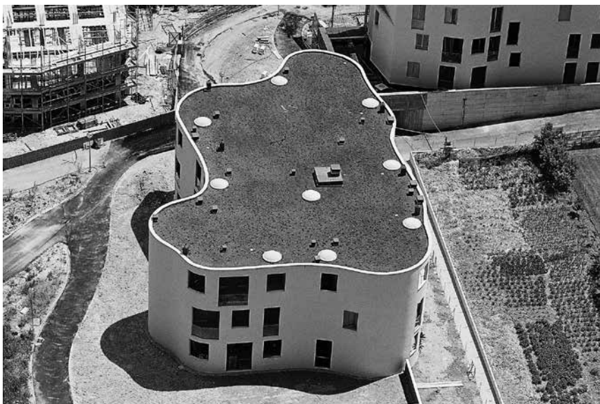
Il controllo dell'architettura nell'area del "Parco Verde Faenza 2002"; edilizia di tipo economico con tetti verdi e impianti sportivi pubblici integrati nel quartiere. Arch. Davide Cristofani, arch. Gabriele Lelli
