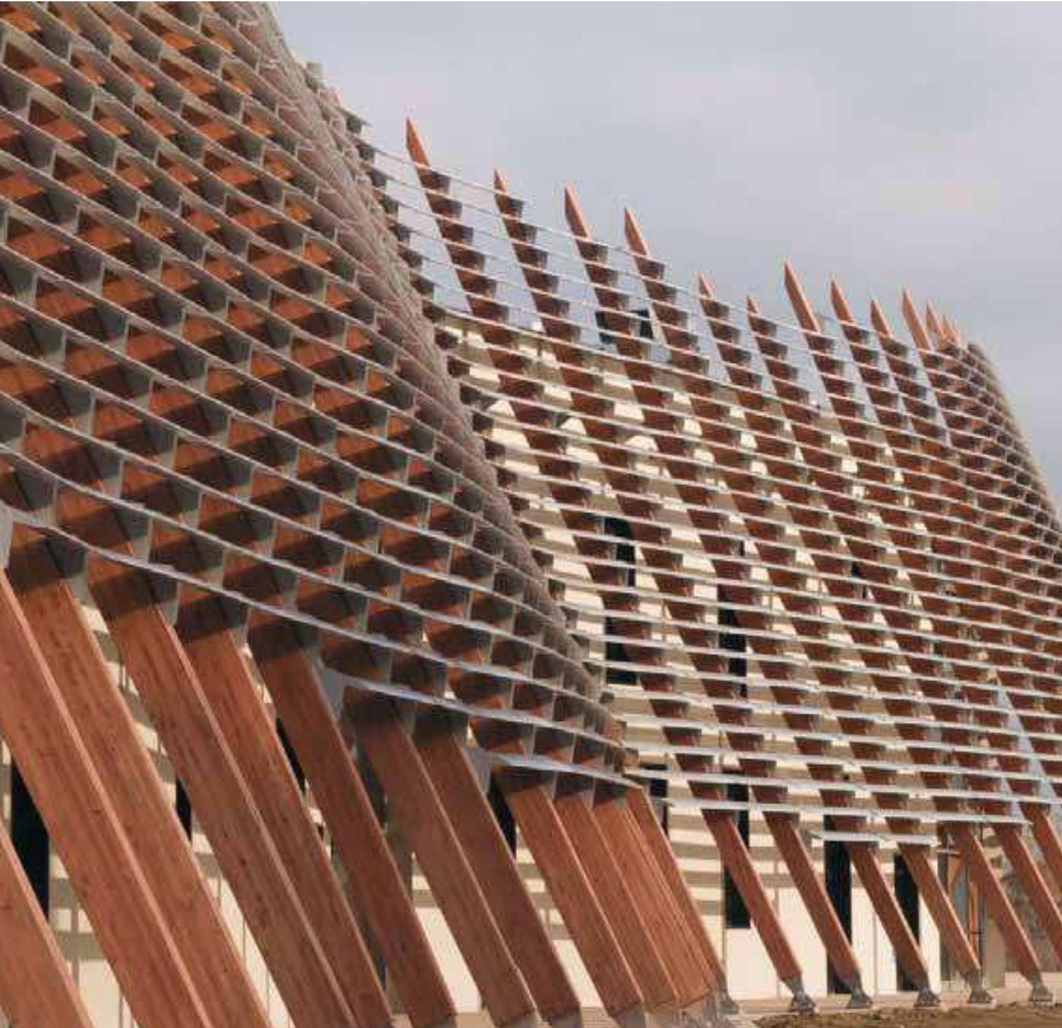
■ Il nuovo incubatore d'impresa. La facciata ventilata orientata a nord e, per questa ragione, con aperture ridotte al minimo, è stata realizzata in elementi ceramici
