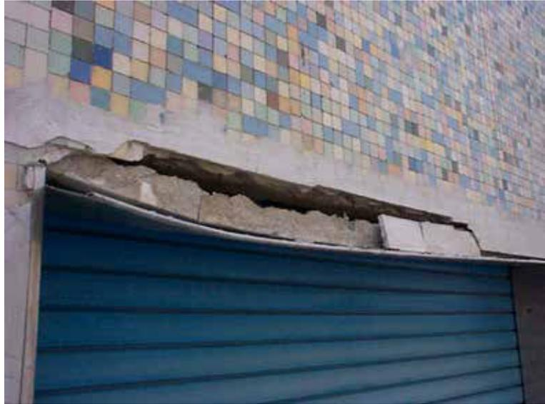
Particolare dello stato del grattacielo prima degli interventi del 2005. Distacco del rivestimento esterno e conseguente ammaloramento del tamponamento in laterizio.
