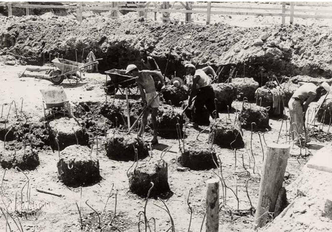
1957 primavera. 210 pali in cemento di 15 metri di profondità con diametro di 53 cm attendono di essere collegati da un'unica platea di fondazione.
