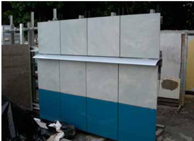
Particolare del montaggio della parete ventilata che ha uno spessore di 13 cm e al cui interno è presente un isolamento in lana di vetro.
